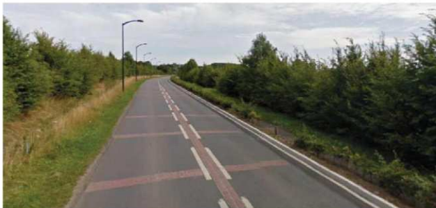
Traitement de la chaussée pour avertir au ralentissement
